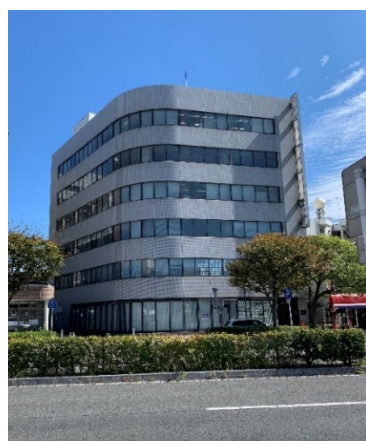
営業所入居ビル外観
